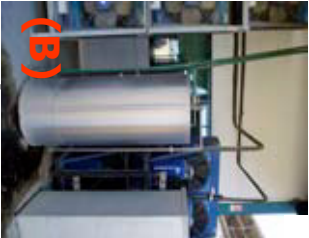
Permutador de calor, com água fria, (A) e armazenamento da água quente da recuperação do calor de condensação do tanque (B)
